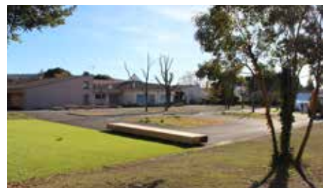
Travaux pour la cour d'école de la Formigueta
